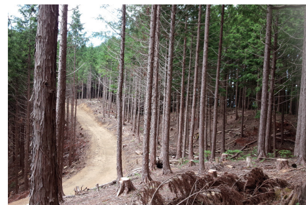
▲郡上市大和町の公社有林の様子 作業道を開設して利用間伐を実施しました。
